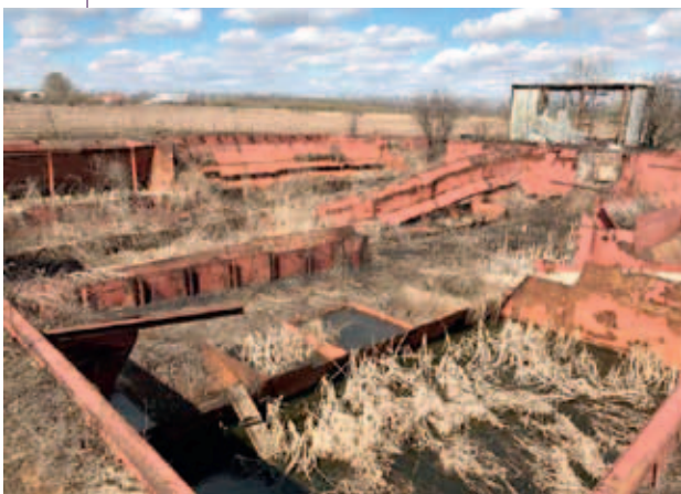
Рис. 2. Выпуск на рельеф коллектора хозяйственно-бытовой канализации от малого населенного пункта в Московской области без очистки.
