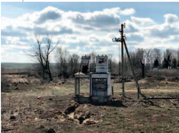
Рис. 1. Разрушенные очистные сооружения малых населенных пунктов.
